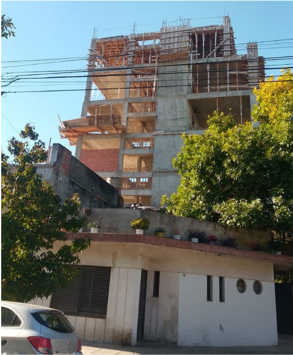
Detalle — Vista lateral / encofrado fachada
